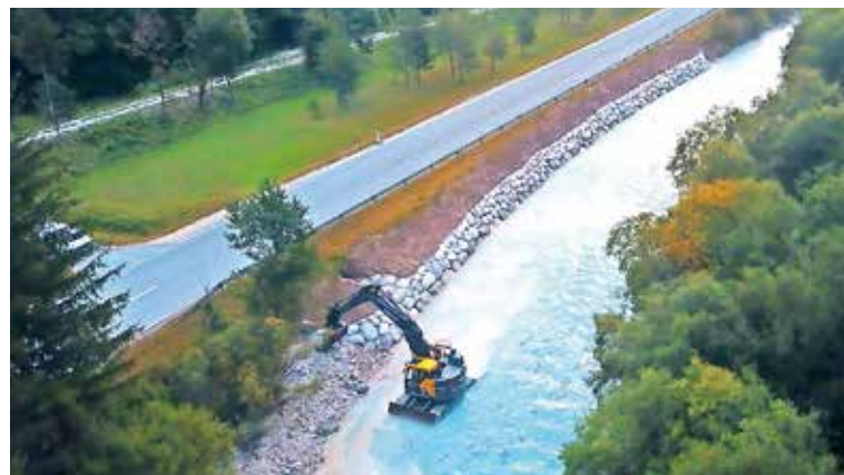
Zavarovanje kanalizacije v brežini pri parkirišču Topolino / Foto: Občina Kranjska Gora
