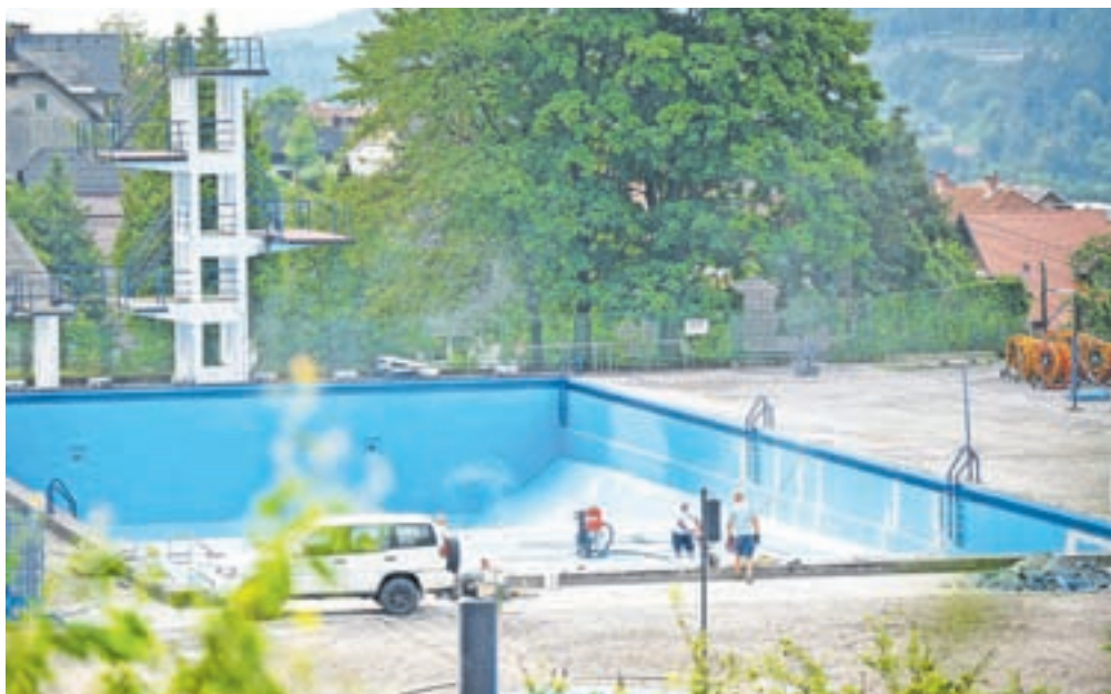
Skupaj s strokovnjaki za bazensko tehniko so ponovno pregledali bazenske naprave in ugotovljene pomanjkljivosti začeli odpravljati. / FOTO: NIK BERTONCELI
