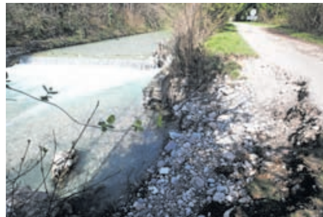
V teh dneh bo stekla sanacija leve brežine reke Kokre, ki je bila poškodovana ob poplavih avgusta lani. / FOTO: GORAZD KAVČIČ
